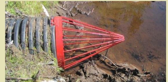
Cône: S'installe au bout d'un ponceau et empêche le castor de boucher l'intérieur du conduit
